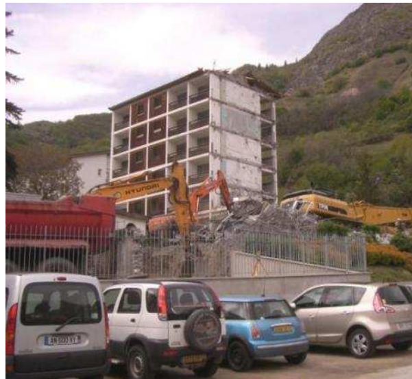
Démolition en site occupé
